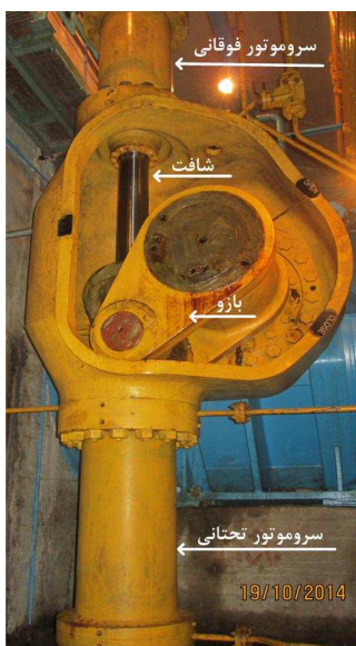
شکل (۱): سیستم هیدرولیک شیر پروانه ای
